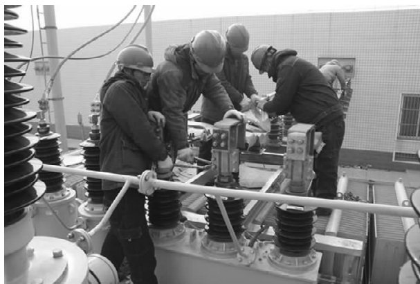
供电安装作业
