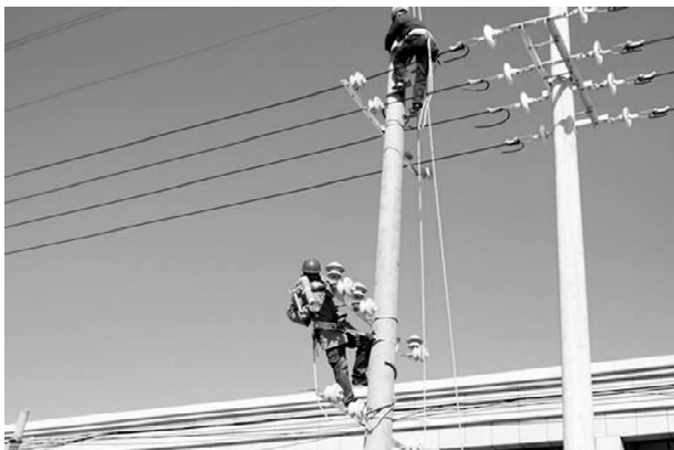
供电网线安装
