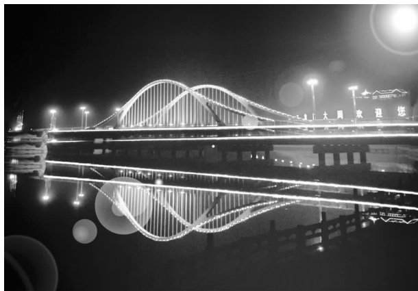
大周黄金大桥夜景
