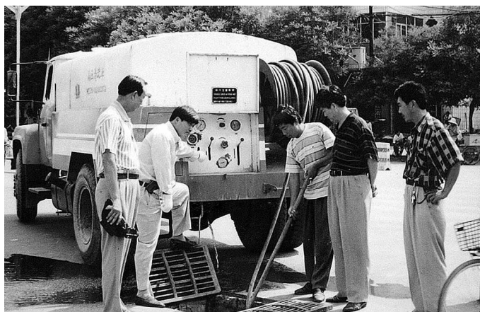
市政排水管道维修
