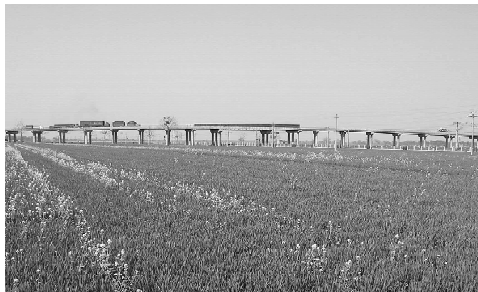
107国道增福庙立交桥
