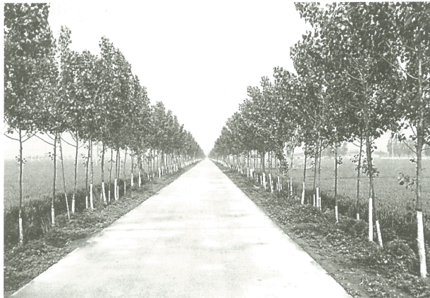
农田改造项目区道路
